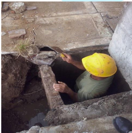
CONEXIÓN DE DOMICILIARIAS A CAJAS DE INSPECCIÓN SANITARIAS
