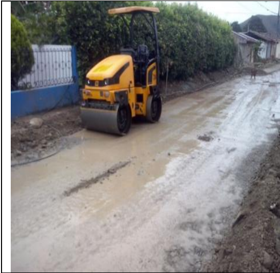
CONFORMACIÓN DE SUB-BASE GRANULAR TIPO ROCAMUERTA PARA VIA DE LA CARRERA 7
